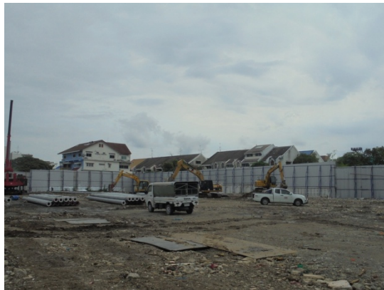
5-9 ปรับสภาพพื้น บดอัดให้เป็นพื้นที่เรียบ วางเหล็กหนาเพื่อเตรียมการทำเสาเข็มฐานราก
