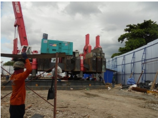
5-10 ใช้เครื่องจักรทำเสาเข็ม วิธีเสาเข็มกด
