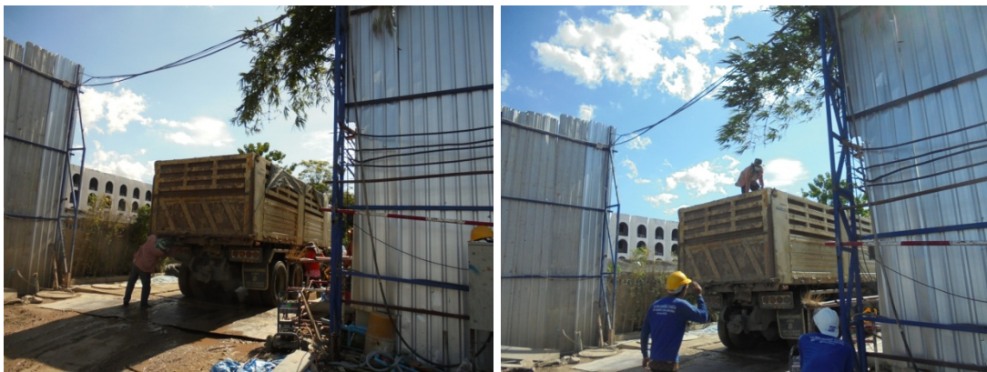
5-11 ล้างล้อรถบรรทุกด้วยสายฉีดน้ำแรงดันสูง และปิดคลุมท้ายกระบะบรรทุกดินอย่างมิดชิด
