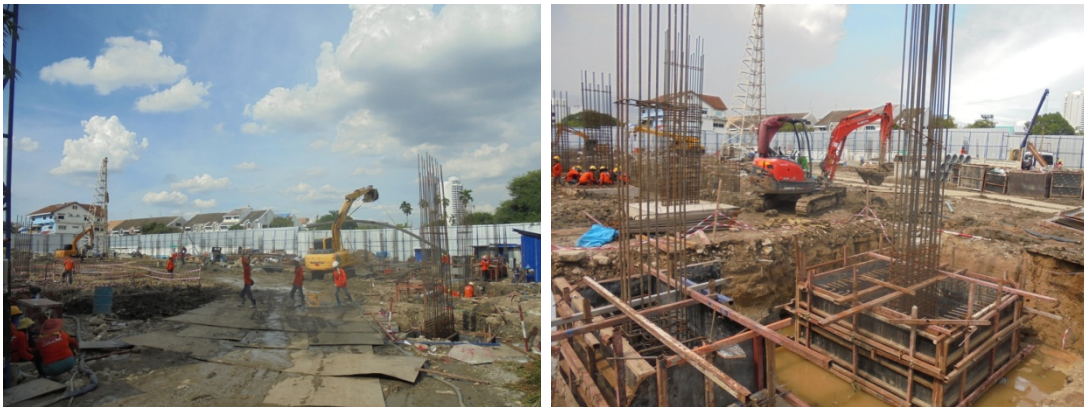
5-12 ก่อสร้างฟุต汀อาคารและปรับปรุงสภาพพื้นที่หลังจากทำเสาเข็มฐานรากแล้วเสร็จ
