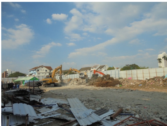
5-7 ขณะทำการรื้อถอนอาคารเดิมฉีดพรมน้ำป้องกันฝุ่นละอองฟุ้งกระจาย ใช้เครื่องจักรหนักในการรื้อถอน
