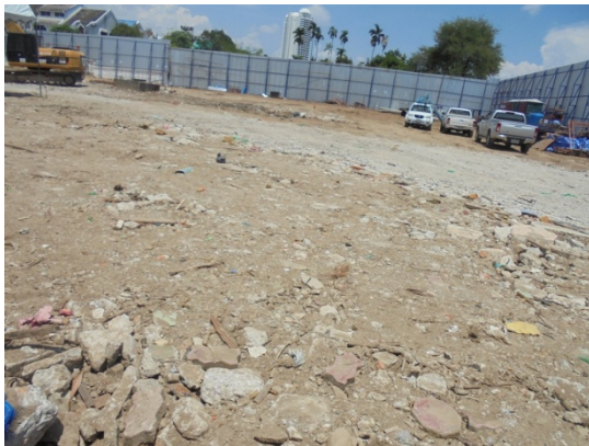
5-9 ปรับสภาพพื้น บดอัดให้เป็นพื้นที่เรียบ วางเหล็กหนาเพื่อเตรียมการทำเสาเข็มฐานราก
