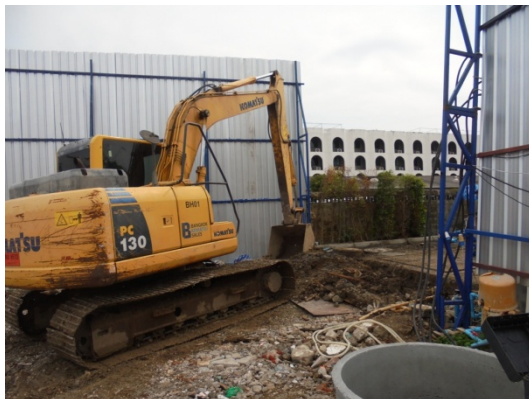
5-10 ใช้เครื่องจักรทำเสาเข็ม วิธีเสาเข็มกด
